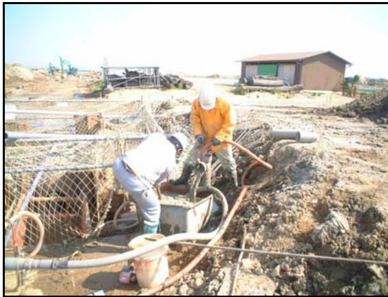
③掘削状況
