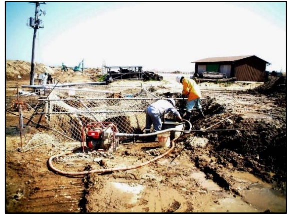
②掘削状況
