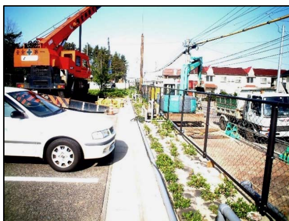
⑧自吸式ポンプ設置状況
